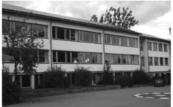
Der Hauptbau mit den Fensterbändern der nach Südost ausgerichteten Klassenräume, am Kopfbau einzelne große Fenster für Lehrerzimmer und Mozartsaal (Foto: Goerlich)
